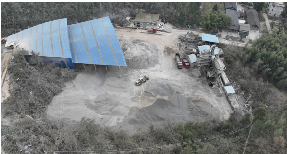
图 3-6 原项目库外堆料现状图
