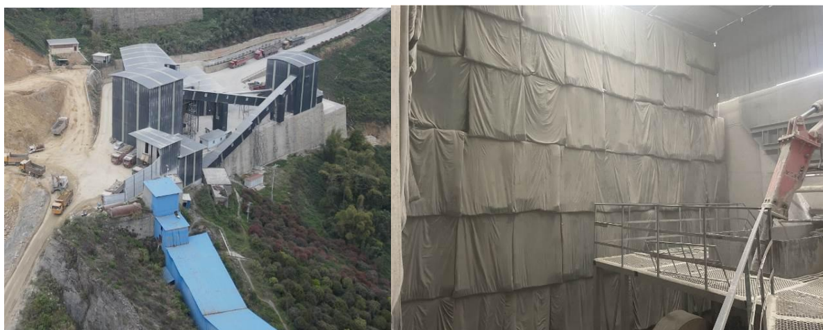
图 6-2 华兴团林采矿场工业广场平面布置及厂房内隔声屏障布置图
