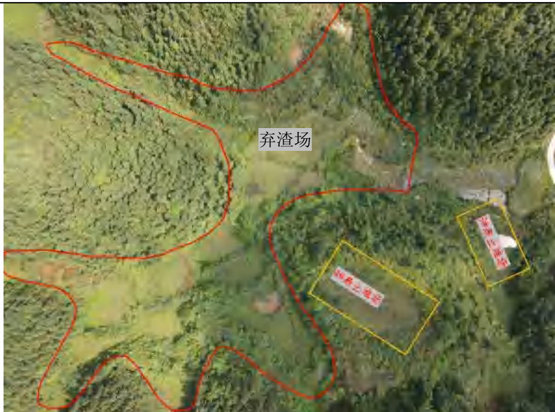
图2.2-3 3#和4#表土堆场现场照片
